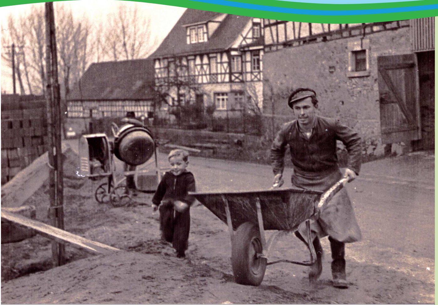
Wie alles anfang: Georg und Klaus Trautmann auf der Baustelle für das ursprüngliche Gasthaus
