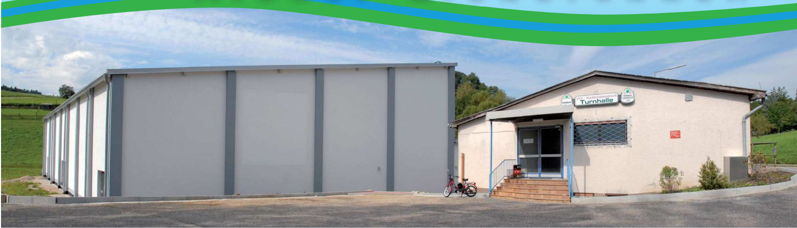
Die neue und die alte SVG - Halle
